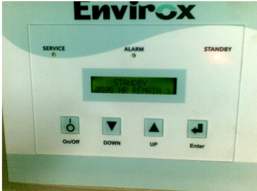
Il Display presente sulla parte anteriore del generatore, ne permette il controllo delle specifiche d'esercizio
